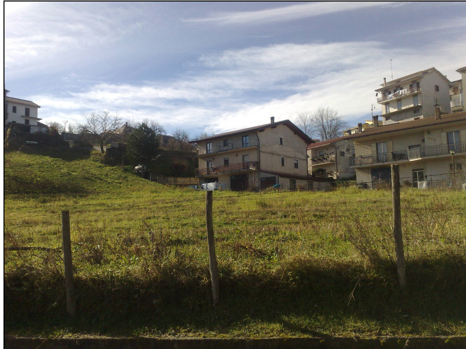
Foto 3: Panoramica della Frana PNT 3
